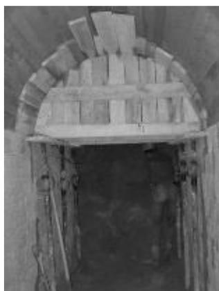
Une équipe spécialisée a procédé au creusement et à la maçonnerie d'une galerie d'une dizaine de mètres de long permettant la liaison d'une grange avec une partie de cave ancienne. C'était une partie délicate car l'excavation a dû être faite en général dans des remblais. Vu l'instabilité et les éboulements, il n'était fait que des travées de 1 m. à 1m50. Cet ouvrage se situe en fin de circuit de visite.
