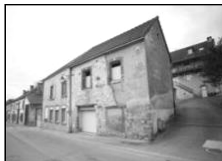
Batiment à rénover pour un nouvel accueil
