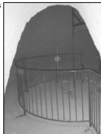
Pose du garde corps dans le puits
